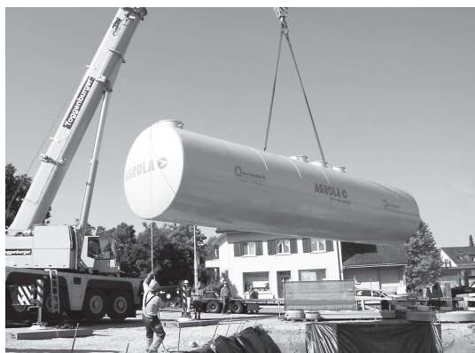
Der 110 000 Liter fassende Tank wird platziert.
