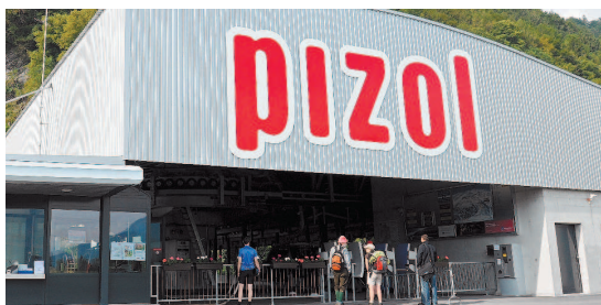
Die Optimierung der Beschneidungsanlage auf der Wangser Seite kostet 2,3 Millionen Franken. (Foto: Pizolbahnen)
